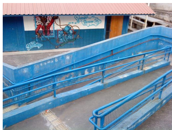
Figura 4 - Rampa de acessibilidade. Ao fundo, a antiga sala da brinquedoteca, onde hoje é a sala de vídeo.
